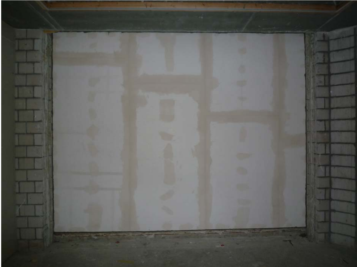
Figuur 3: Aan de ontvangtzijde zijn de naden tussen de Permoxxboard platen en de schroefgaten afgefilmd met Knauf Uniflott.
