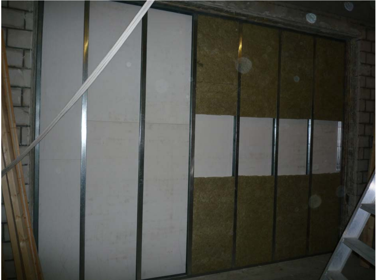
Figuur 2: Plaatsing Permoxx scheidingswand MS 100/1.75.1.A
